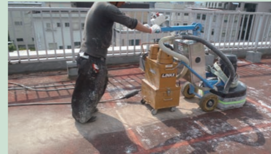
⑤シームレス工法用緩衝防水材施工
