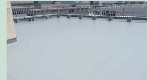
⑧シームレス工法用トップコート塗装・施工完了
