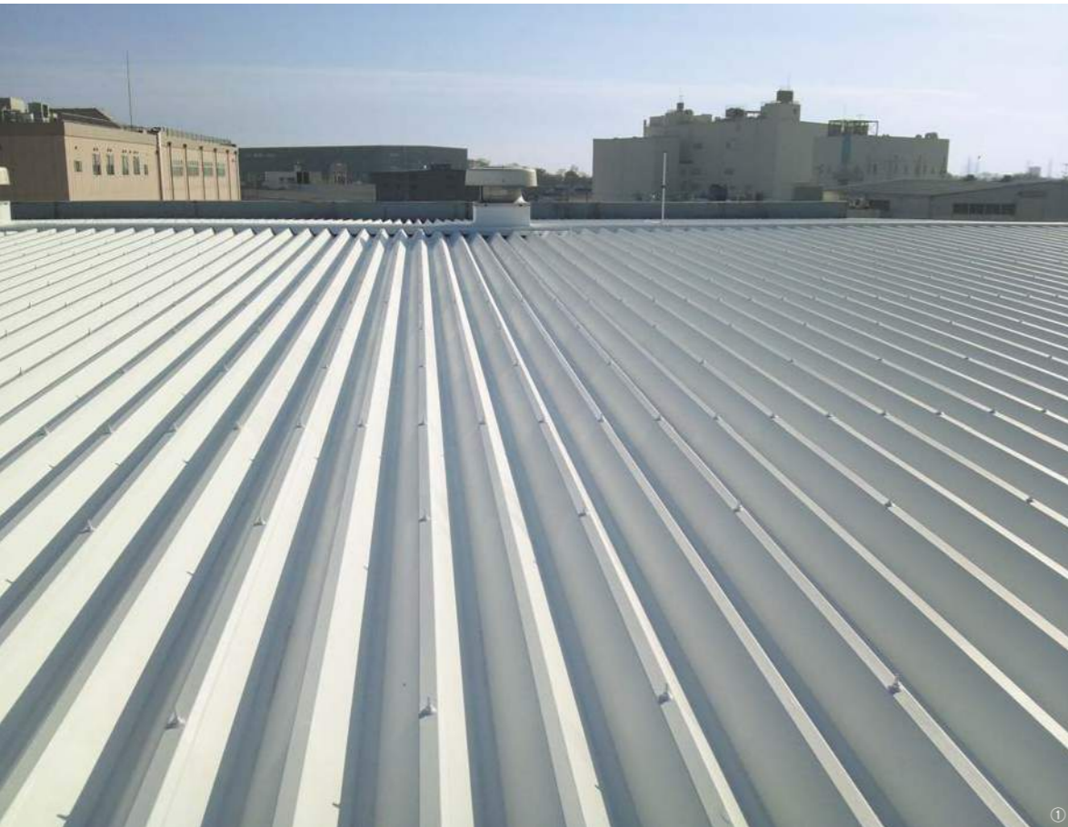
①遮熱塗料のミラクールは、建物の屋根や外壁に塗ることで室温の上昇を抑える効果がある。②模型を使った実験装置では、一般的な塗装を行った屋根の温度が63.8℃まで上昇したのに対し、ミラクールを塗った屋根は36.8℃と、27℃も低かった。③シロキコーポレーションは、施工業者の独自ネットワークを構築している。塗料の販売から施工までを一貫してコントロールすることで高い工事品質を保つ。④中空セラミックバルーンと特殊顔料の相乗効果によって太陽光を反射、温度上昇を抑える
